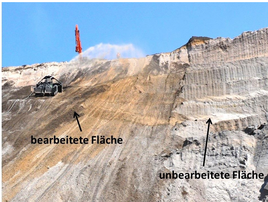
Abbildung 3: Böschung vor (rechts) und während (links) des Pully-Einsatzes
